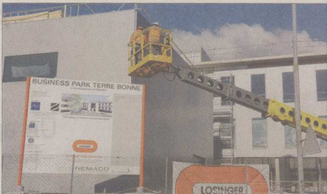
C'est dans le centre d'affaires de Terre Bonne, toujours en construction, que Shire PLC s'installera en septembre. Archives La Côte
